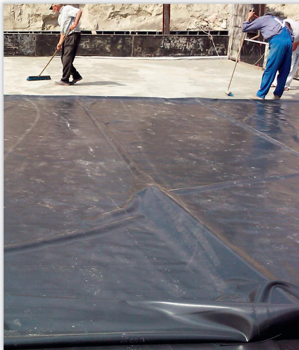
Folia hydroizolacyjna Izowinyl. Szczelna izolacja przeciwno wody płyty fundamentowej.
