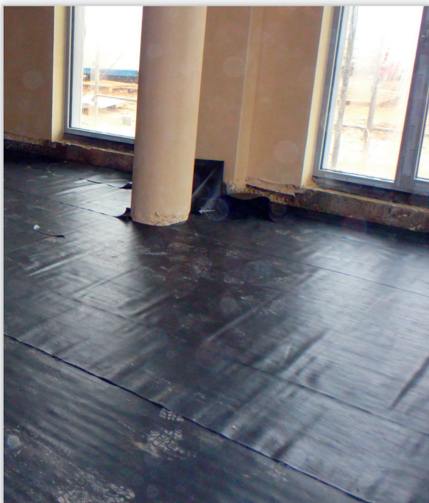
Folia hydroizolacyjna Izowinyl. Izolacja posadzki.
